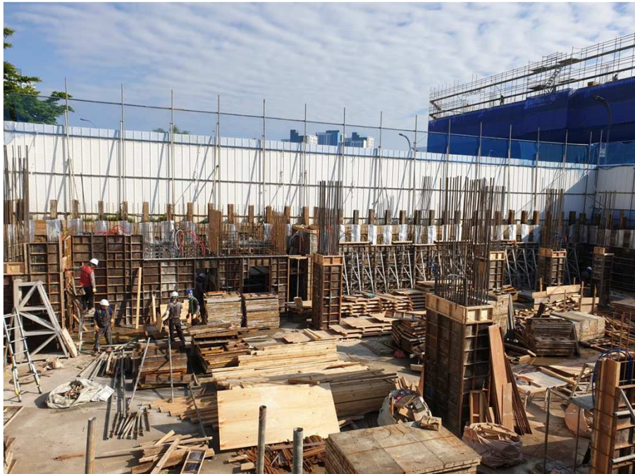
지하1층 거푸집 설치 전경
