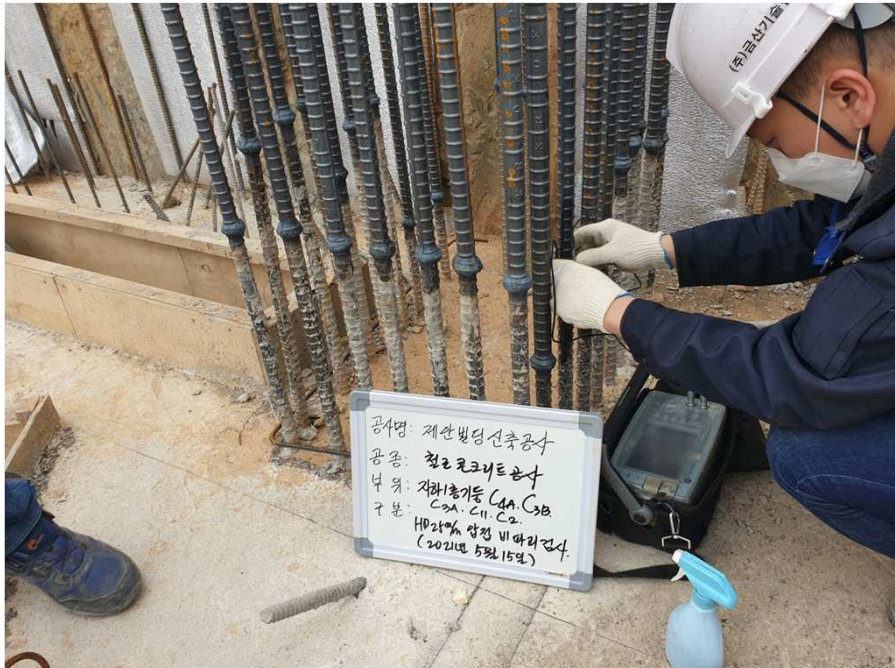
지하1층 기둥 압접 및 비파괴검사(M.T검사=초음파탐사)
