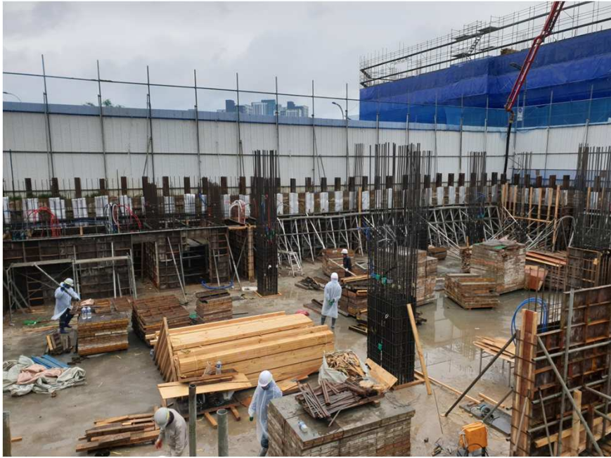
지하1층 옹벽 1단 콘크리트 타설
