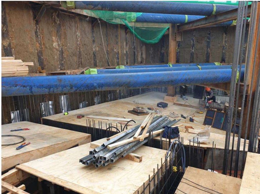
지하1층 바닥 형틀설치
