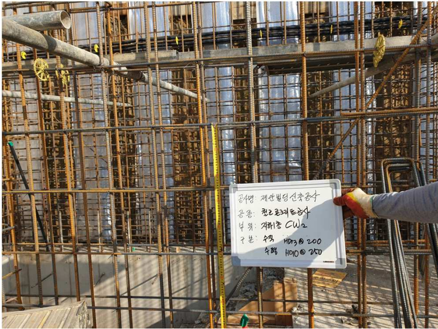
지하 1층 옹벽 철근배근
