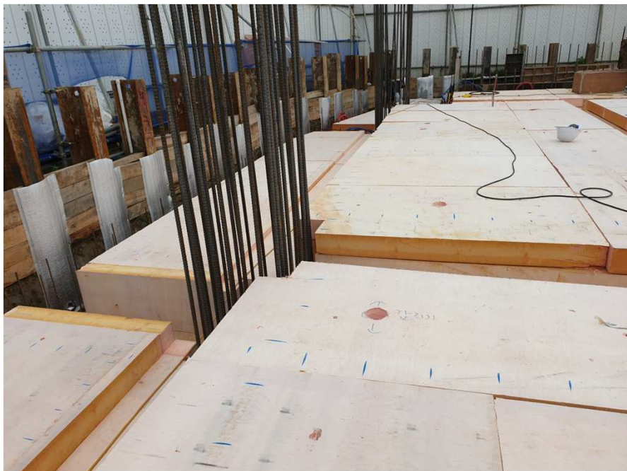
1층 바닥 단열재 160MM 설치
